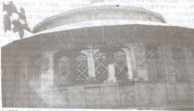
የደብረ በንኮል አቡነ መድኃኒን እግዚእ ገዳም ቤተ ክርስቲያን
